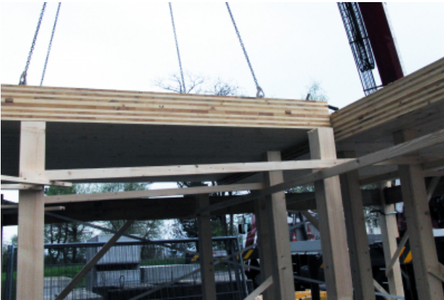
Montage der CLT Platten
