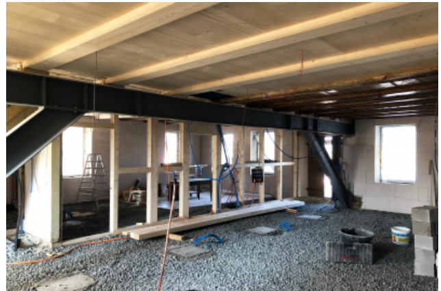
Stahlträger im Altbau
