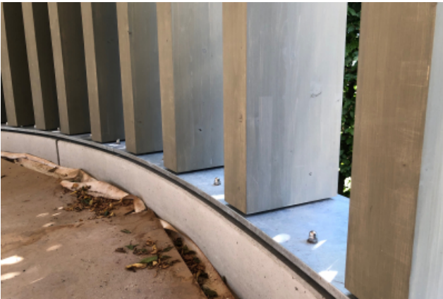
Stützen beim Pavillon
