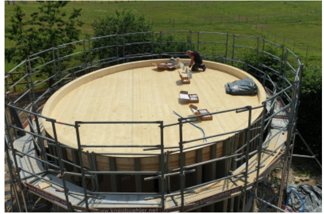
Verguss der TS3 Fuge
