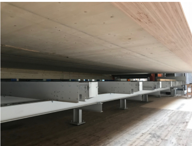
Blick auf die Konstruktion der Plattform von unten
