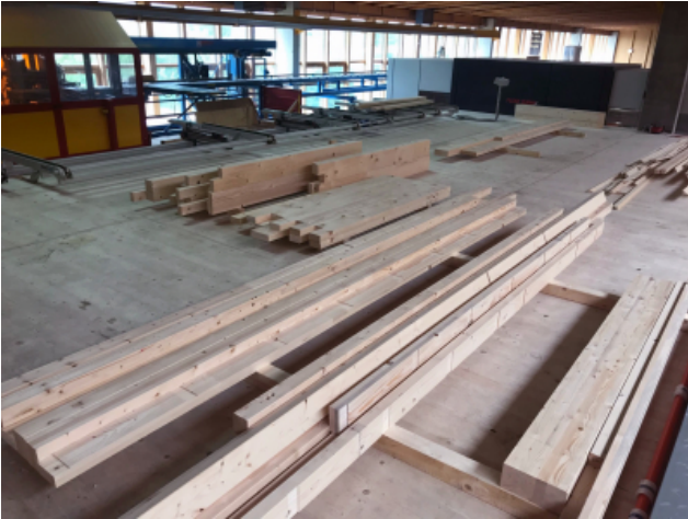
Plattform im Betrieb
