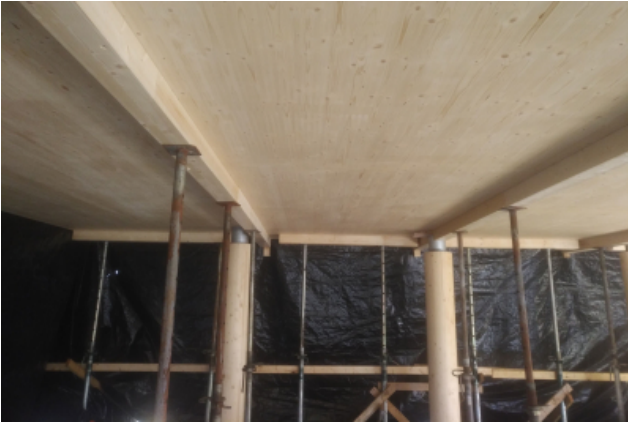
Abdichten der Fugen von der Unterseite
