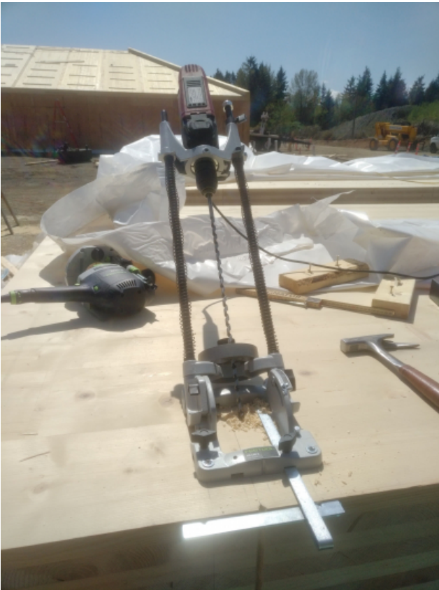
Bohrung der Löcher für das Einfüllen des Gießharzes
