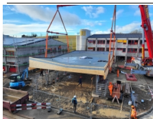
Überdachung Kaserne, Chamblon , Chamblon
