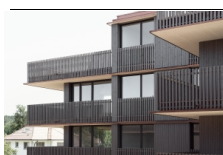
Mehrfamilienhäuser Unterhub, Zollikerberg
