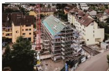
Ersatzneubau Raiffeisenbank, Gebenstorf
