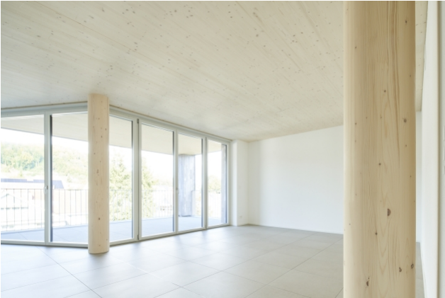
Dank der tragenden Stütze sind die Wände nicht tragend und können einfach verschoben werden.
