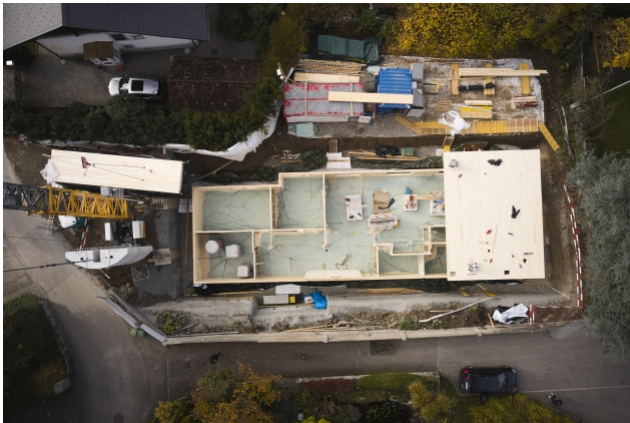
Was lange unmöglich schien, ist heute Realität: In Thun steht das erste Mehrfamilienhaus mit einem Keller komplett aus Holz.
