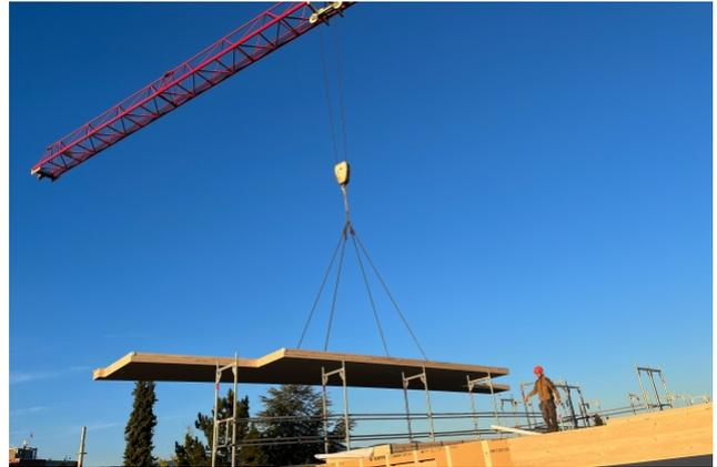
Das bestehende Mehrfamilienhaus aus den 80er Jahren an der Bahnhofstrasse in Busswil wurde durch einen Anbau erweitert und mit einem Attikageschoss aufgestockt. Mit dem TS3-System konnte die Aufstockung ohne Raumhöhenverlust durch Unterzüge den baurechtlichen Rahmen voll ausschöpfen.
