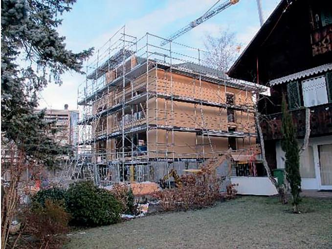
Abb. 26: Baustelle eines mehrgeschossigen Wohnhauses in Thun, Switzerland
