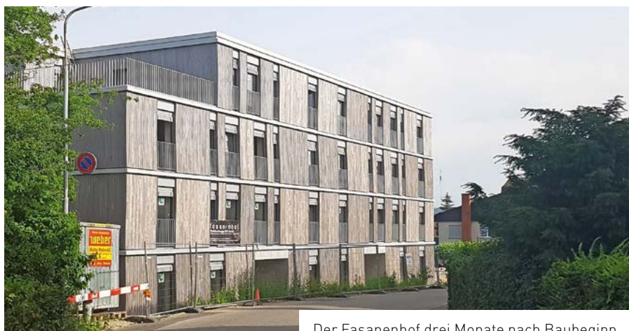
Der Fasanen Hof drei Monate nach Baubeginn
