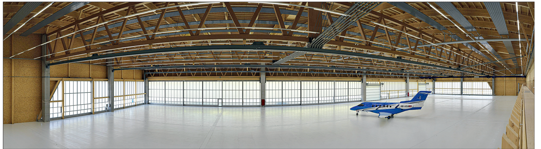
Fachwerkträger aus Buchen-Furnierschichtholz überspannen diese neue Flugzeughalle im schweizerischen Stans auf einer Länge von über 100 m. Foto: Neue Holzbau
