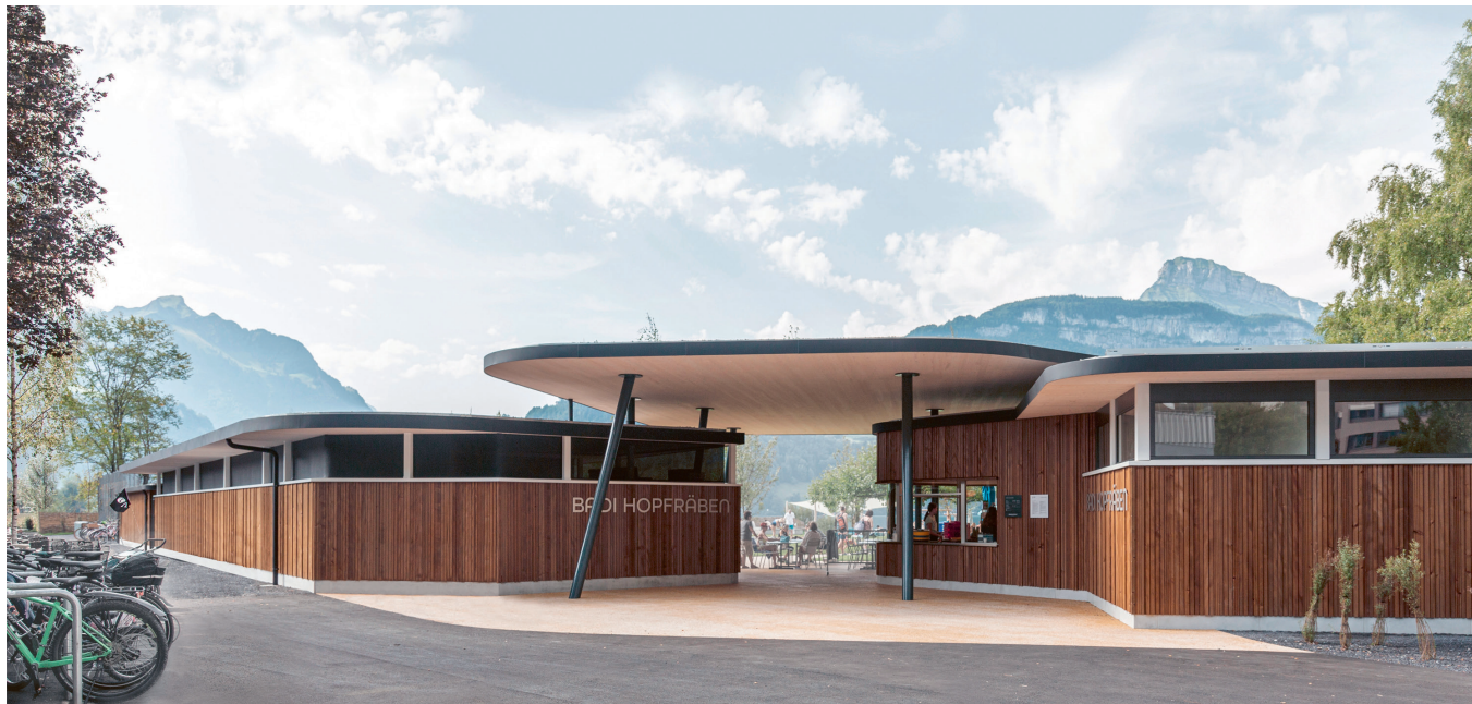
Den Eintritt in die Badi in Brunnen bei Schwyz überspannt ein luftiges Holzdach.
