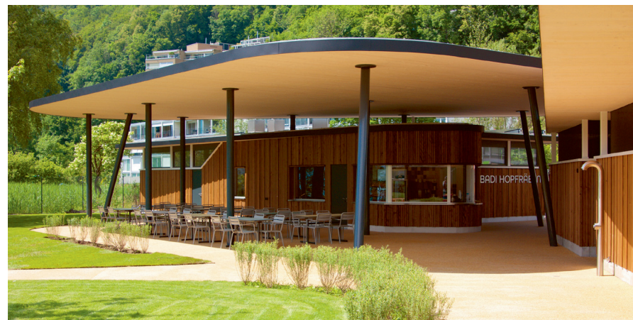
Das stirnseitig verbundene Brettsperrholz kommt ohne Schrauben und Metallplatten aus.
