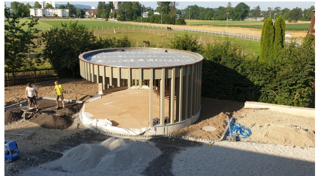
Travaux de construction autour du pavillon
