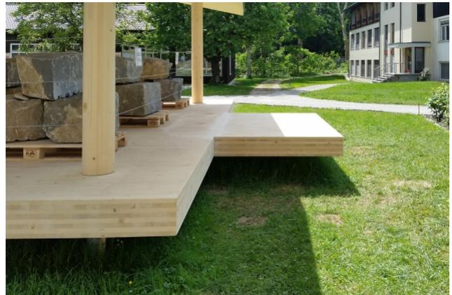
Poteaux, panneaux, c'est fini : dans la cour intérieure de la Haute école spécialisée bernoise à Bienne se trouve un banc d'essai permanent avec la nouvelle technologie TS3 et le premier balcon au monde à être collé en façade. Les nouvelles possibilités pour la construction en bois sont ainsi clairement mises en évidence.
