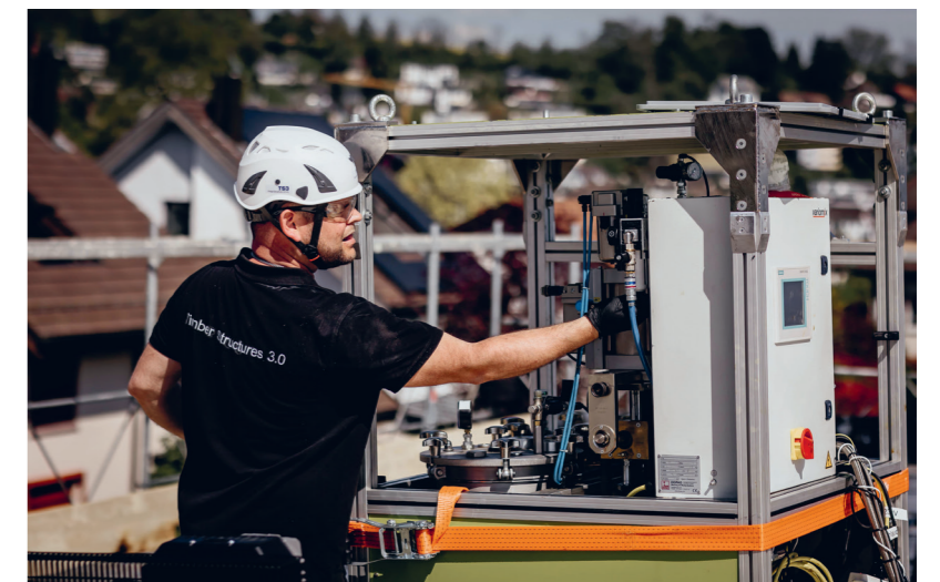
Scellement des joints TS3 avec un appareil de scellement
