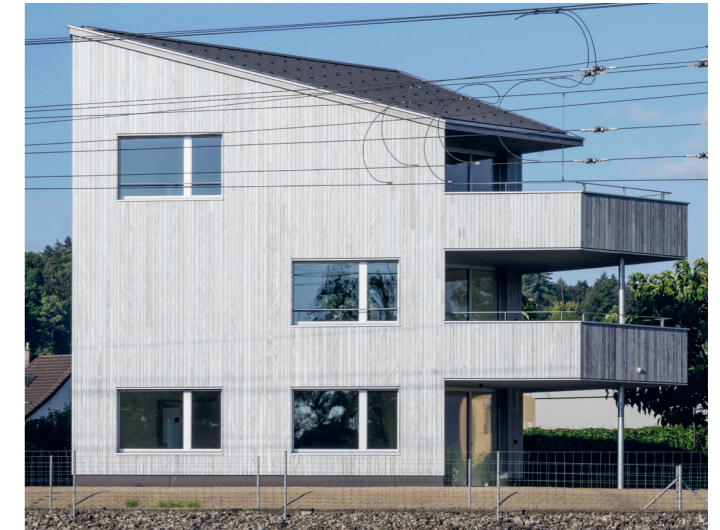
Immeuble collectif, Buchs
