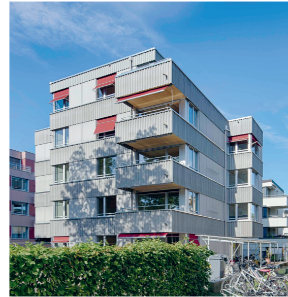
Immeuble collectif Wehntalerstrasse, Zürich
