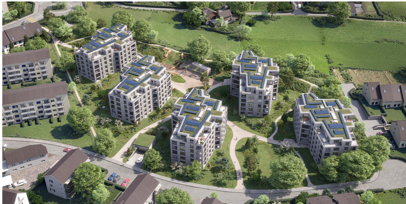
Lotissement résidentiel im Zelg, Uster. 5 immeubles d'habitation avec un total de 164 logements.
