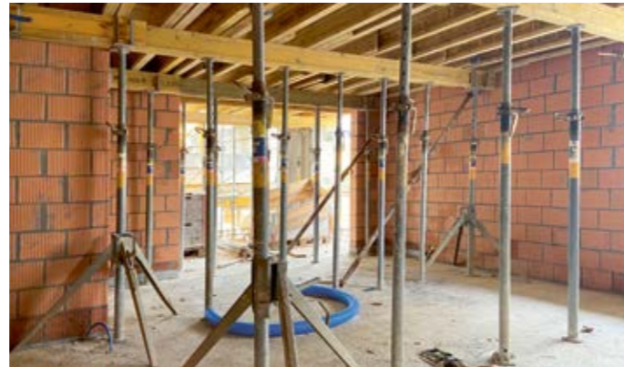
Les dalles en béton armé nécessitent nettement plus de poteaux en raison de leur poids plus élevé.
