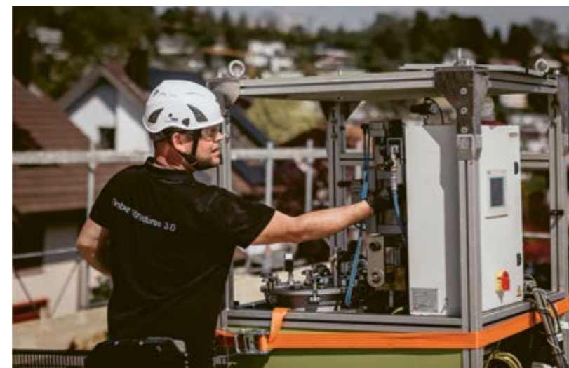
Scellement de joints TS3 avec un appareil de scellement
