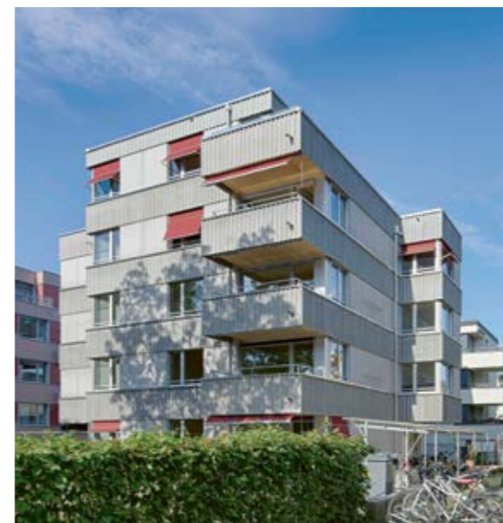
Immeuble collectif Wehntalerstrasse, Zürich
