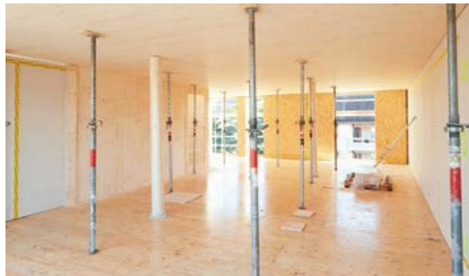
Grâce à un soutien provisoire minimal, les corps de métier ci-après peuvent se mettre au travail avant même le scellement des joints.
