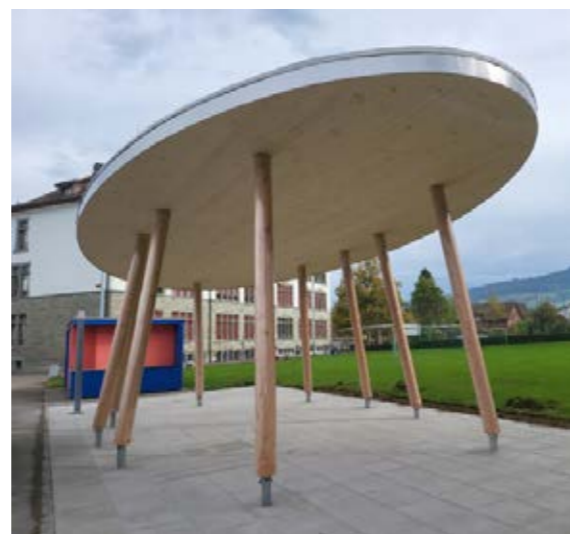
Abri Pausenplatz, Goldach
