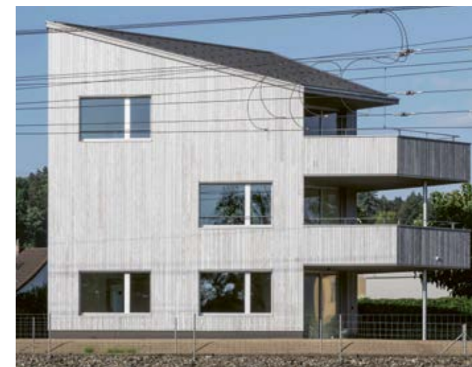
Immeuble collectif, Buchs
