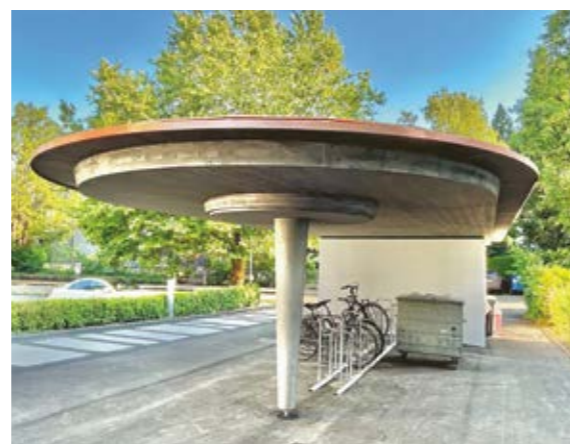
Abri Jurastrasse, Aarau
