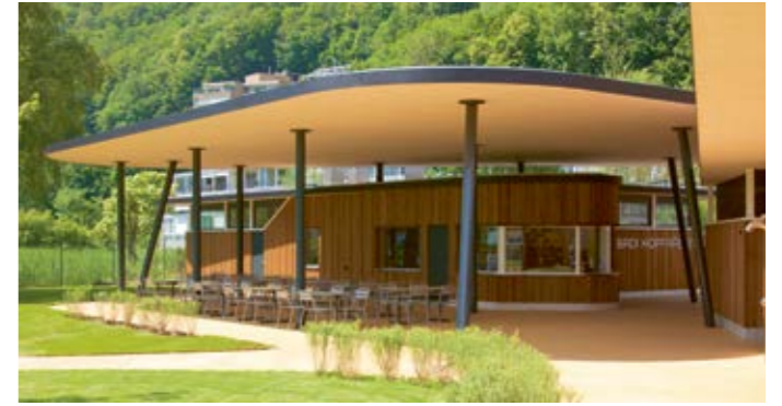
Public bath Hopfräben, Brunnen
