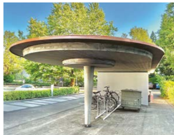
Shelter Jurastrasse, Aarau
