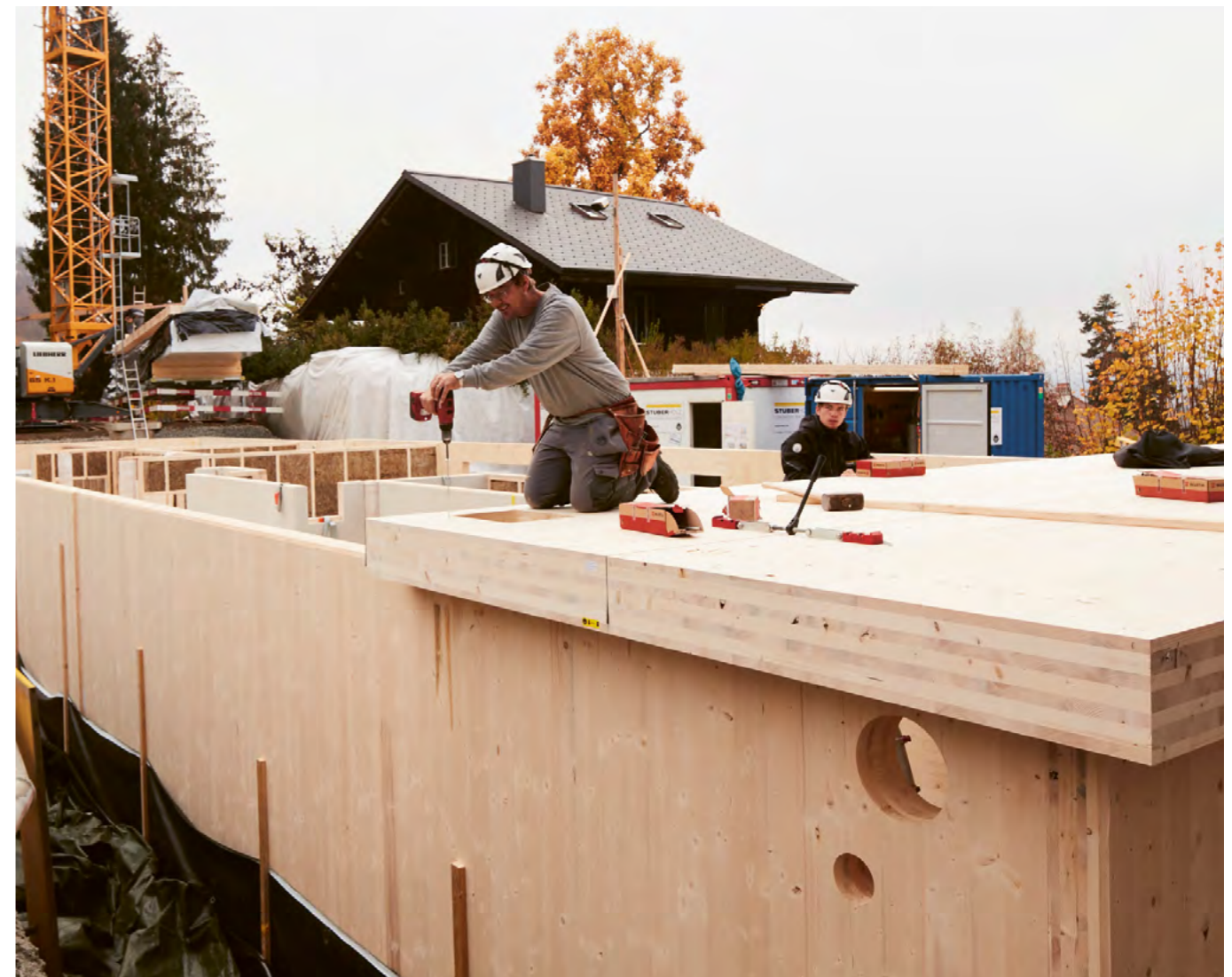
5 Die Brettsperrholzplatte über dem Untergeschoss dient als Lastverteilplatte für das Erdgeschoss.
