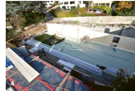
4 Danach werden die Wände aus Brettsperrholz aufgestellt.
