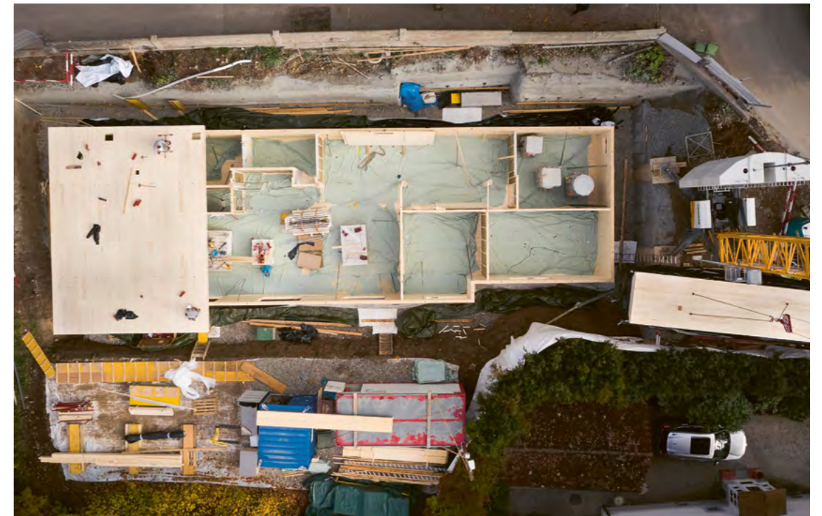
Das Untergeschoss aus Holz von oben gesehen.
