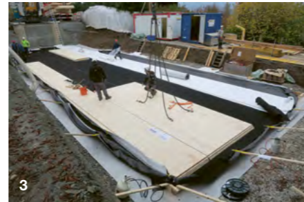
3 Die Bodenplatte aus Brettsperrholz wird auf die Abdichtung und das vollflächige Feuchtemonitoring gelegt.
