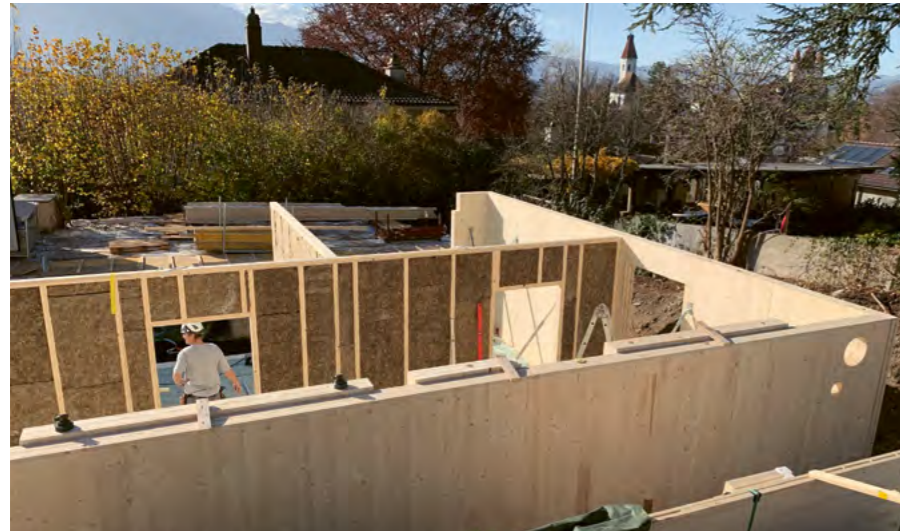
Das Untergeschoss in Holzbauweise ermöglicht eine deutlich kürzere Bauzeit.
