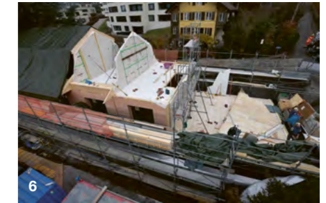
6 Darauf wird das Holzgebäude vom Holzbauunternehmer aufgerichtet.
