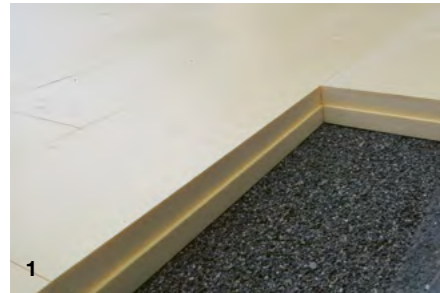
1 Auf einer Splitt-Schicht werden dicke Dämmplatten verlegt.
