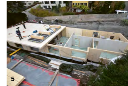
5 Die Brettsperrholzplatte über dem Untergeschoss dient als Lastverteilplatte für das Erdgeschoss.
