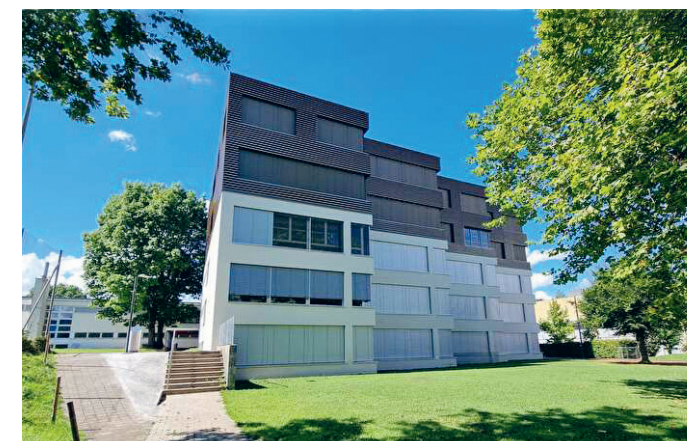
Schulhaus Feld 1, Richterswil
