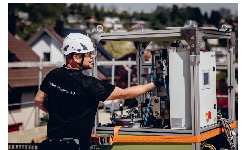
Verguss TS3-Verbindung auf der Baustelle mit Vergussgerät
