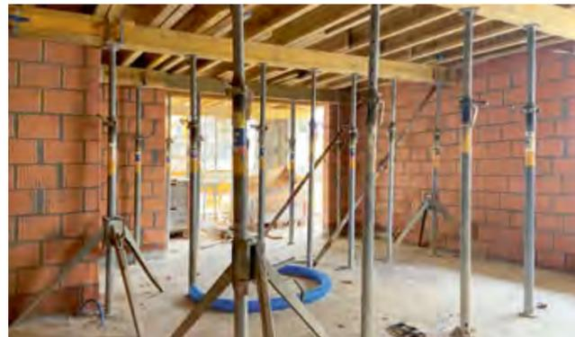
**Bei Stahlbetondecken sind wegen des höheren Gewichtes viel mehr Baustützen notwendig.**
