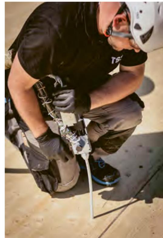
Verguss TS3-Verbindung auf der Baustelle mit Vergussgerät
