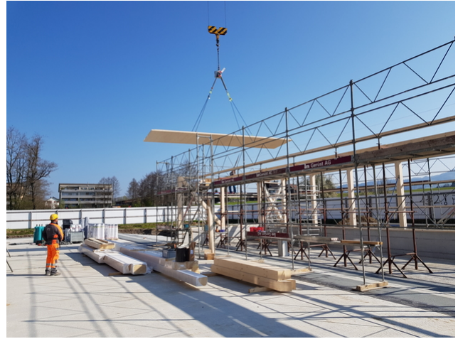
Montage der CLT-Platten
