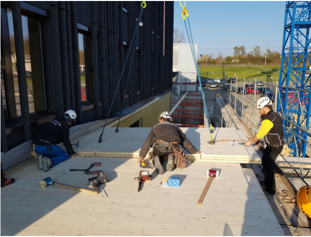
Montage der CLT-Platten
