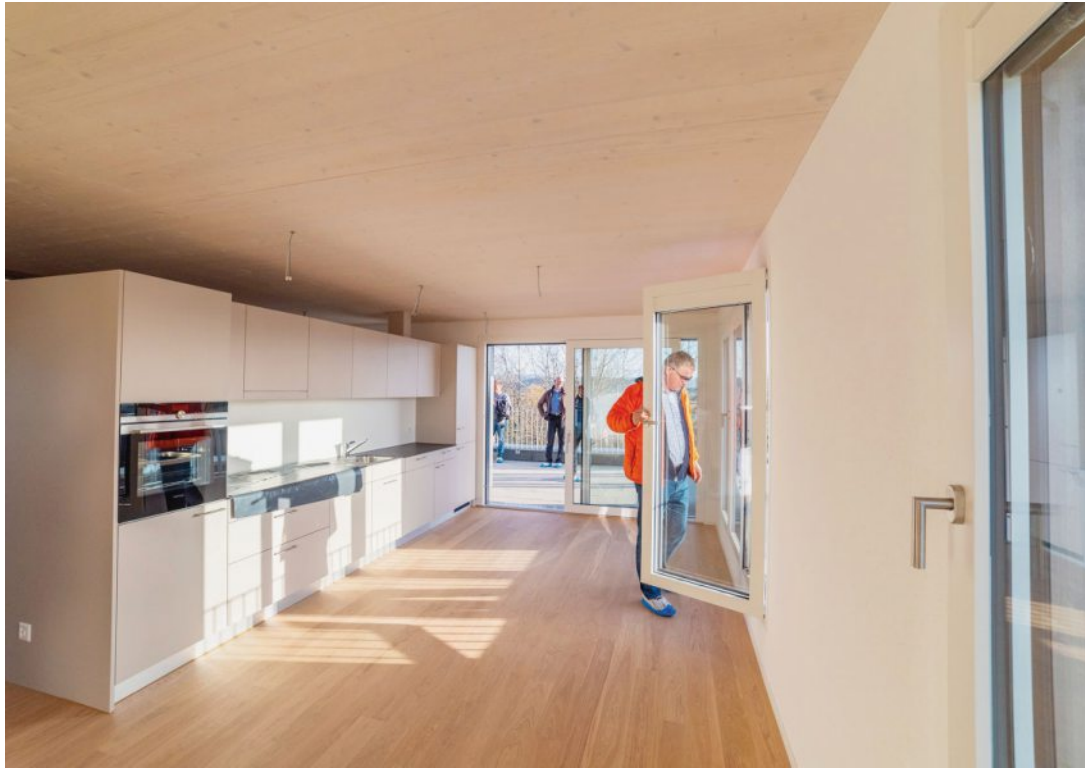
TS3 Technologie für Decken ohne Unterzüge: So begeistert man Ingenieure und Architekten. NICO KOBEL
